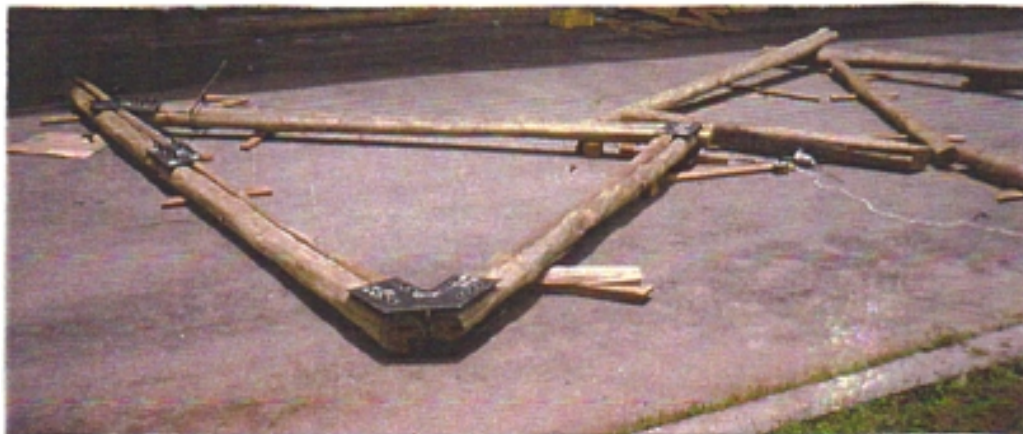
FIGURA 1. Presentación de un pórtico preservado con sales CCA en el estacionamiento del LNPF, con la colocación de pernos y platinas
